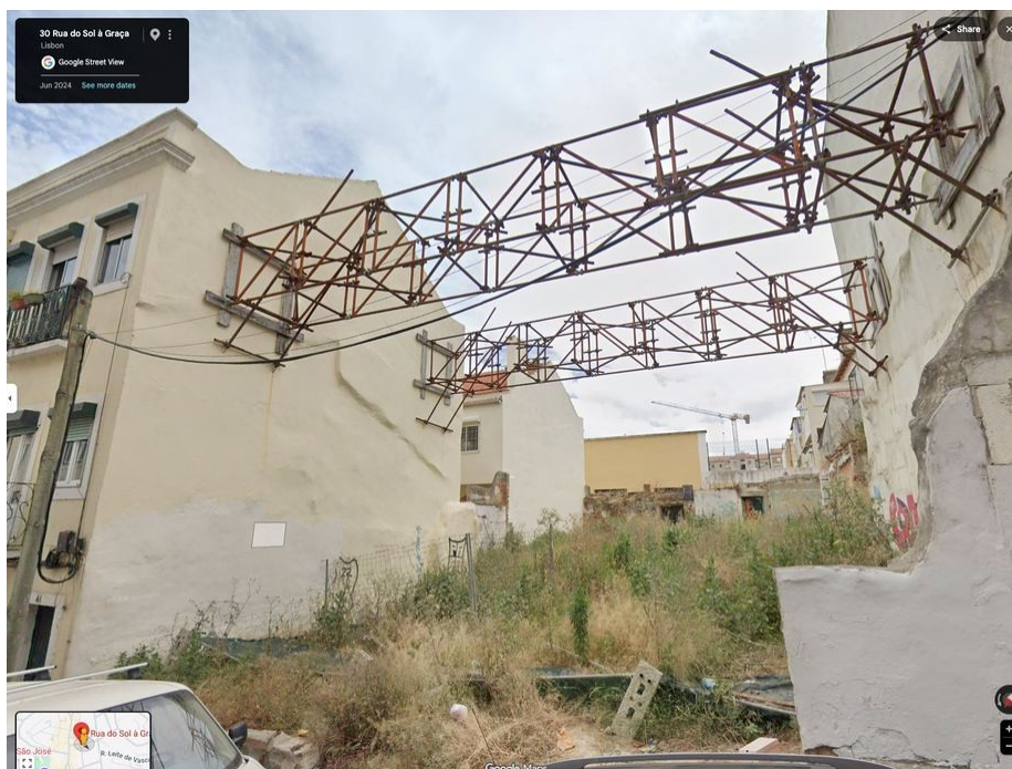
Fig. 2 — Imagem ao nível da rua, 30 Rua do Sol à Graça, Lisboa, junho de 2024. A mesma estrutura de suporte permanece em vigor uma década depois, mais de um ano antes do incidente de setembro de 2025.
