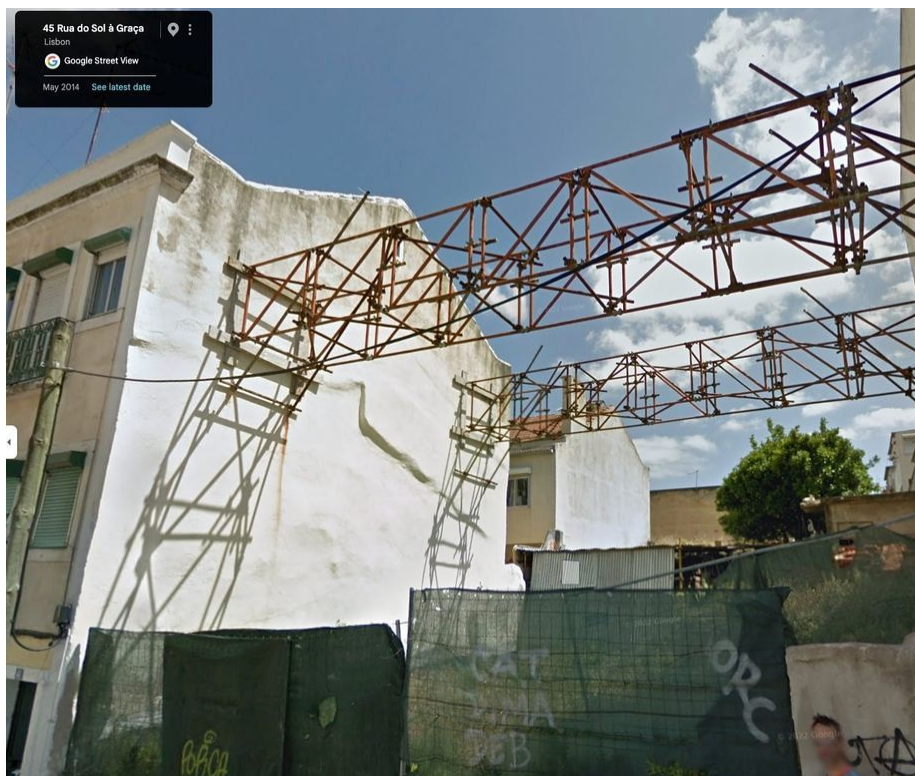
Fig. 1 — Imagem ao nível da rua, 45 Rua do Sol à Graça, Lisboa, maio de 2014. Um sistema de treliça metálica já vence o vazio entre as duas estruturas, fornecendo suporte lateral externo a ambas.
